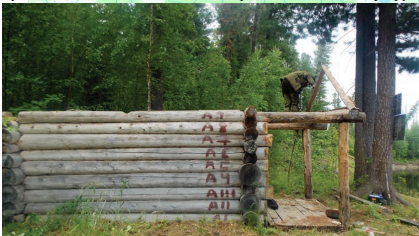
Ремонт избушки в устье Вуаян. Фото из архива заповедника
